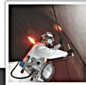
トンネル点検
